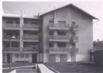
30 ALLOGGI DI EDILIZIA RESIDENZIALE PUBBLICA A NOVA MILANESE, MILANO 1995-1997
