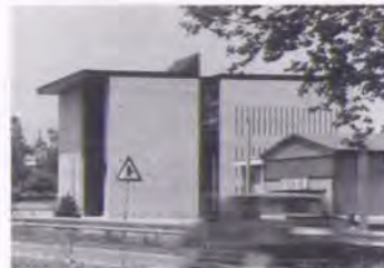
CENTRO ESPOSITIVO DAMIOLI A PONTE S. MARCO, BRESCIA 1996-1998
